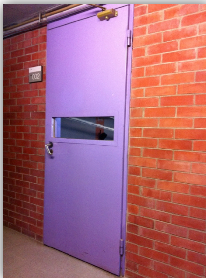
Figura 7. Apertura de cristal en la puerta de acceso al aula. Fuente: Cátedra de Accesibilidad UPC
