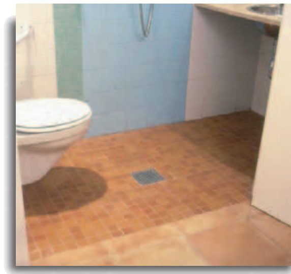
Fig. 9 y 10. Es sencillo conseguir pavimentos antideslizantes para baños pero la dificultad estriba en la limpieza. Pavimentos muy rugosos acumulan partículas que resultan difíciles de eliminar mientras que soluciones de doble pavimento retienen la humedad y favorecen la proliferación de microorganismos.
