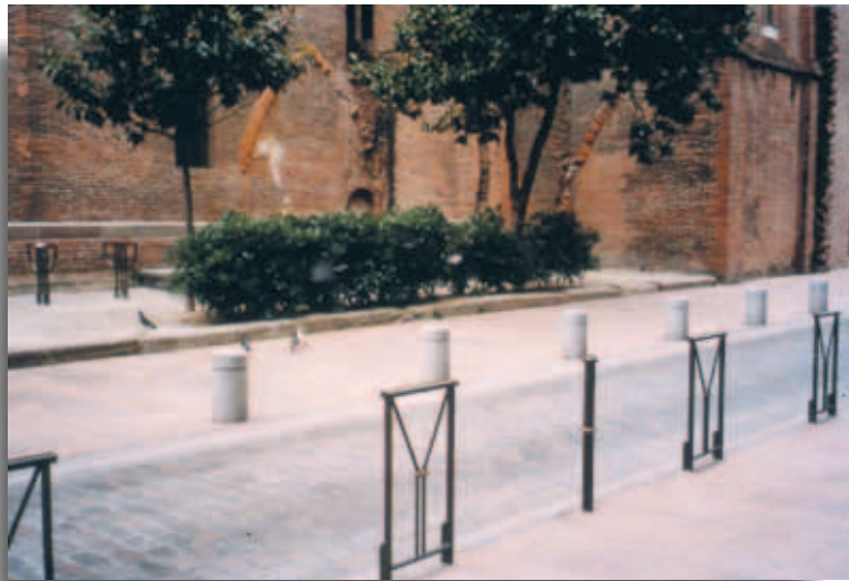
Delimitación de aceras mediante bolardos y vallas. Toulouse.
