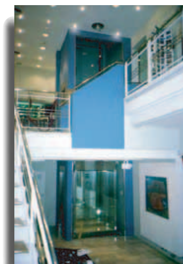
Fig. 11 y 12. Una correcta utilización del ascensor permite resolver situaciones complejas. Este local con escasa superficie a nivel de calle se convierte en accesible mediante un ascensor de doble puerta que permite acceder al semisótano y al altillo.
