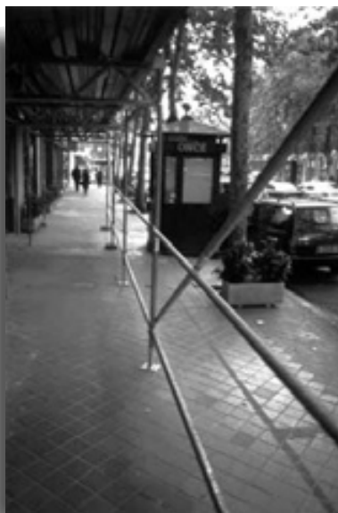
Protección de diagonales de rigidización y montantes con barandilla y barra intermedia.
