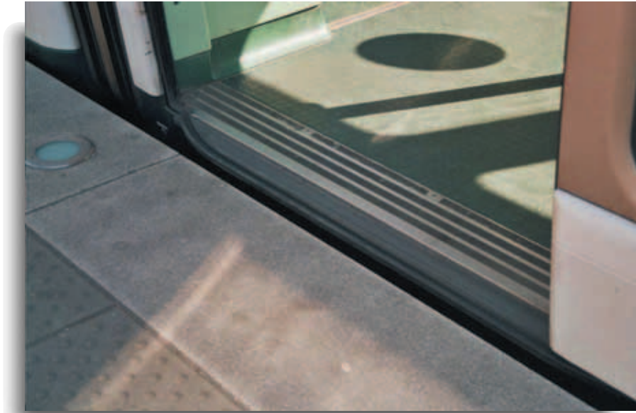
Tranvía de Estrasburgo. Holgura y desnivel entre coche y andén.
