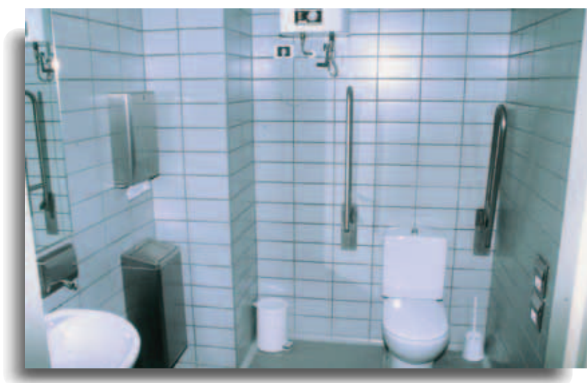
Fig. 28. Ejemplo de aseo adaptado diferenciado. Palacio Regional, Oviedo.
