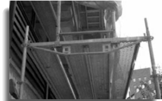
Otro ejemplo de viga en andamio multidireccional.
