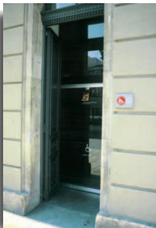
Fig. 27. Ejemplo de puerta histórica abierta con otra moderna accesible hacia el interior. Centro de Cultura Antiguo Instituto Jovellanos, Gijón.
