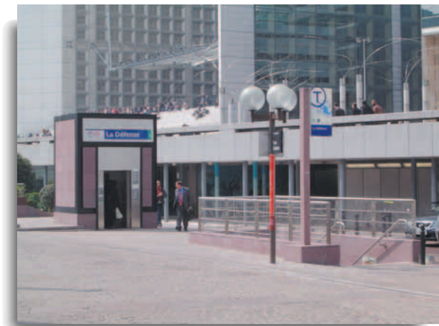
Tranvía de París. Ascensor de acceso a estación La Défense
