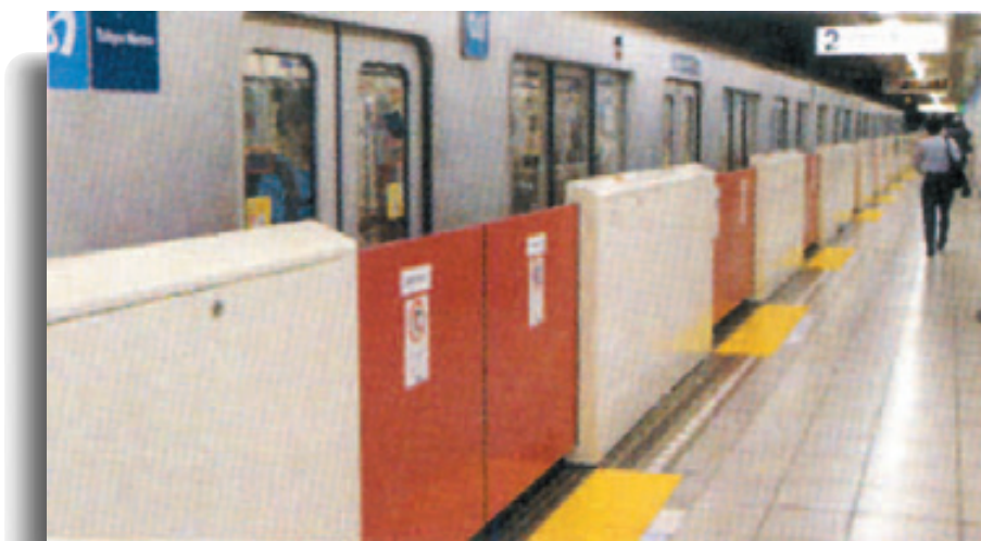
Plataformas delimitadoras de zona de seguridad de andenes. Metro de Tokio.
