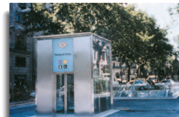
Ascensor del metro de Barcelona.
