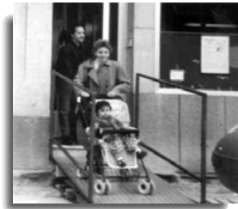
Pasarela de peatones utilizada durante los trabajos de rehabilitación de una calle.
