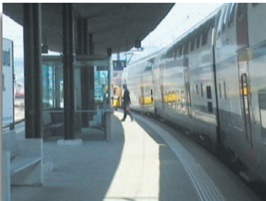
Detalle de andén, con franja de aviso de borde.
