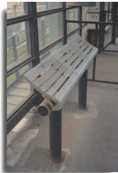
Estación de Cercanías de París. Apoyos isquiáticos en andenes.
