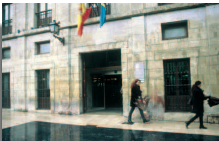
Fig. 18. Ejemplo de eliminación de escalón de entrada, en la zona exterior pública.
