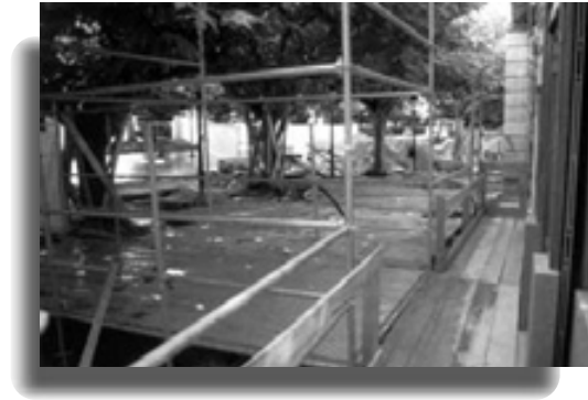
Detalle del pasillo de madera protegido con barandillas.
