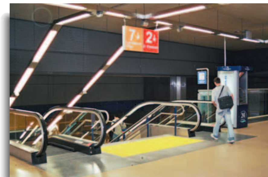
Señalización vertical vestíbulo. Metro de Madrid.
