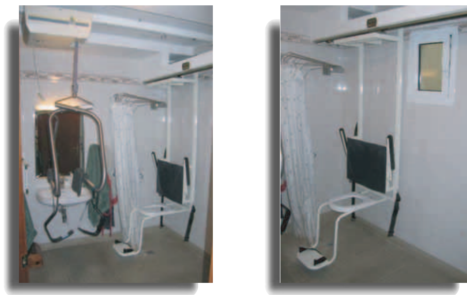
Fig. 33 y 34. Piso adaptado por ByJ Adaptaciones, Barcelona. Mejorar la autonomía y seguridad de uso de la vivienda puede requerir dispositivos específicos, como una grúa para desplazarse hasta el baño y un asiento móvil para poder utilizar la ducha y el inodoro sin ayuda de terceros.
