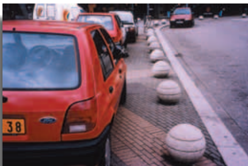
Bola de granito inadecuada.
