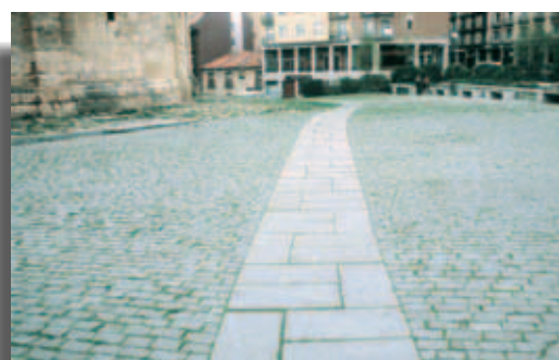
Fig. 7. Detalle de la solución anterior: la accesibilidad se consigue sin renunciar al uso de pavimentos tradicionales.
