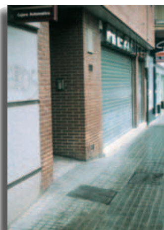
Fig. 19. Ejemplo de eliminación de escalón de entrada integrada en la acera de la calle.
