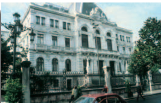
Fig. 25. Ejemplo de edificio con escalera de entrada monumental. Palacio Regional, Oviedo.
