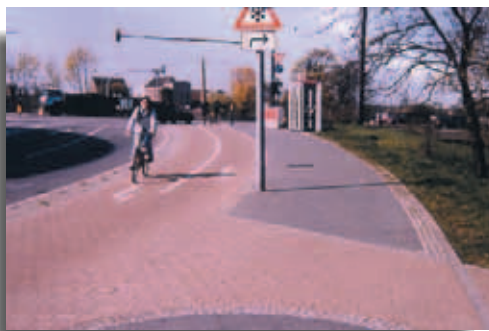
Acera y carril bici. Diferenciación de pavimentos, textura y color.
