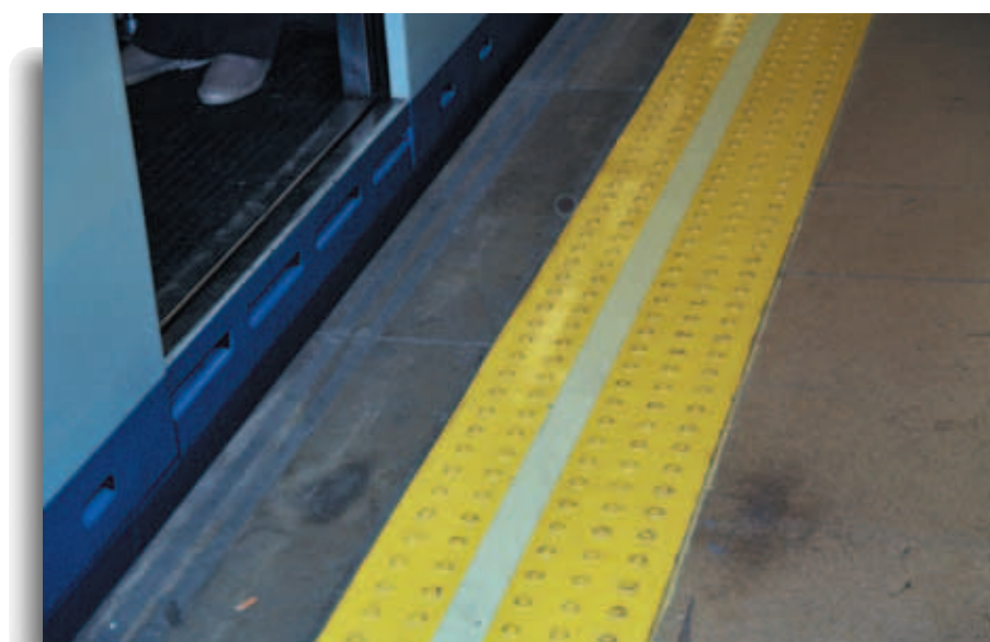
Franja de señalización y seguridad al borde del andén. Metro de Madrid.
