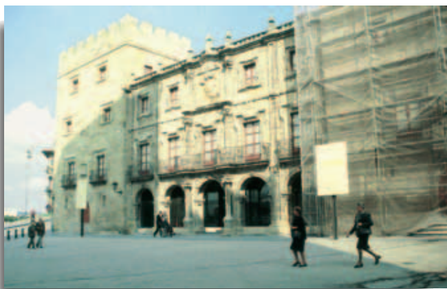
Fig. 20. Ejemplo de acceso con rampa y escalones situados tras los arcos de entrada. Palacio de Revillagigedo, Gijón.
