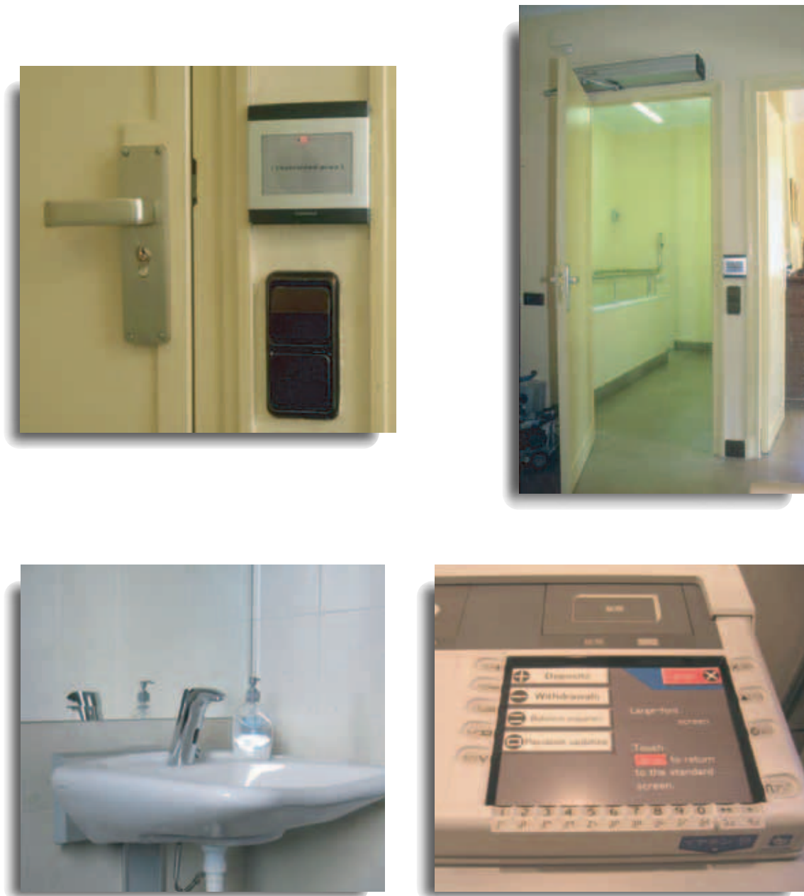
Fig. 15, 16, 17 y 18. Existen sistemas de apertura automática de puertas muy sencillos de instalar y fiables, mientras que los grifos sin mando manual son accesibles y economizan agua. Teclado de cajero automático con indicaciones en “braille” y hendiduras para facilitar su uso a personas con motricidad poco fina.
