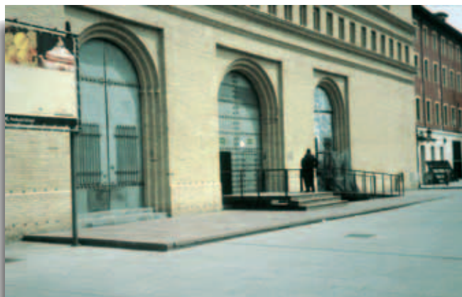
Fig. 22. Ejemplo de estructura independiente para facilitar el acceso. Lonja de Mercaderes, Zaragoza.
