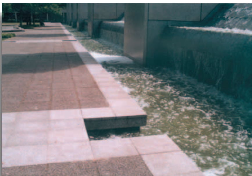
Zonas ajardinadas, zonas de tránsito, de césped y de láminas acuosas sin suficiente contraste delimitador. Parque de La Villette de París.
