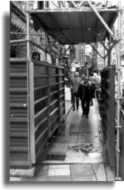
Paso protegido en el exterior de la acera.
