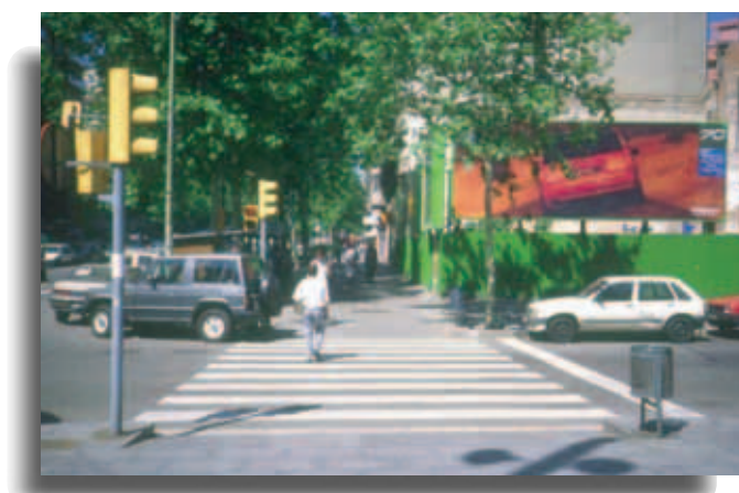
Fig. 1, 2, 3 y 4. La resolución con elementos urbanos accesibles y normalizados del cruce de circulaciones peatonales y vehiculares en el entorno urbano ha experimentado un gran avance en los últimos años. El ejemplo presenta una gama de vados para vehículos compuesto por piezas normalizadas de 20, 40 y 60 cm. de ancho (según altura y amplitud de la acera) que respetan la continuidad del recorrido peatonal y el vado peatonal de 120 cm., que integra papeleras y semáforo como elementos de uso, delimitación del paso peatonal y protección del desnivel lateral, incorpora una franja central perpendicular como encaminamiento para invidentes, utiliza material fácil de mantener y antideslizante (granito abujardado) y ofrece piezas especiales para encuentros curvos.
