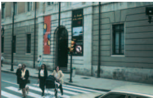
Fig. 23. Muchas veces no es posible la disposición de un rampa en la entrada principal del edificio. Centro de Cultura Antiguo Instituto Jovellanos, Gijón.
