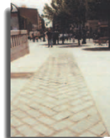
Encaminamientos en la Plaza de Lavapiés. Madrid.
