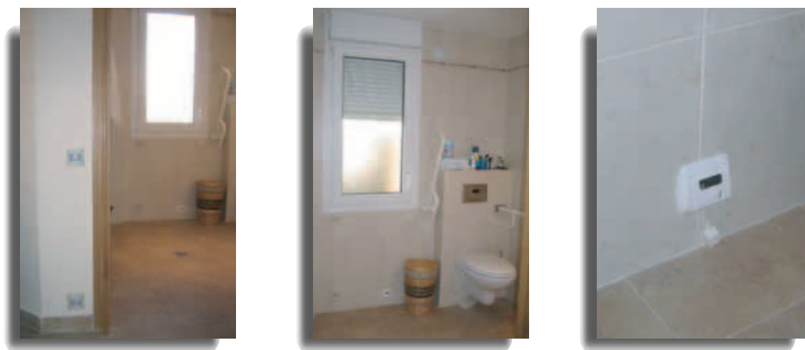
Fig. 30, 31 y 32. Apartamentos para personas con gran discapacidad del Centro Dato, Madrid. Las funciones en materia de seguridad pueden ajustarse a necesidades específicas, como detectar caídas (sensores de presencia a dos niveles que actúan coordinadamente) o salidas incontroladas de agua (grifos abiertos en duchas, fugas, etc.).
